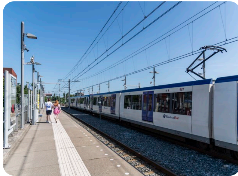
Station Pijnacker Zuid
